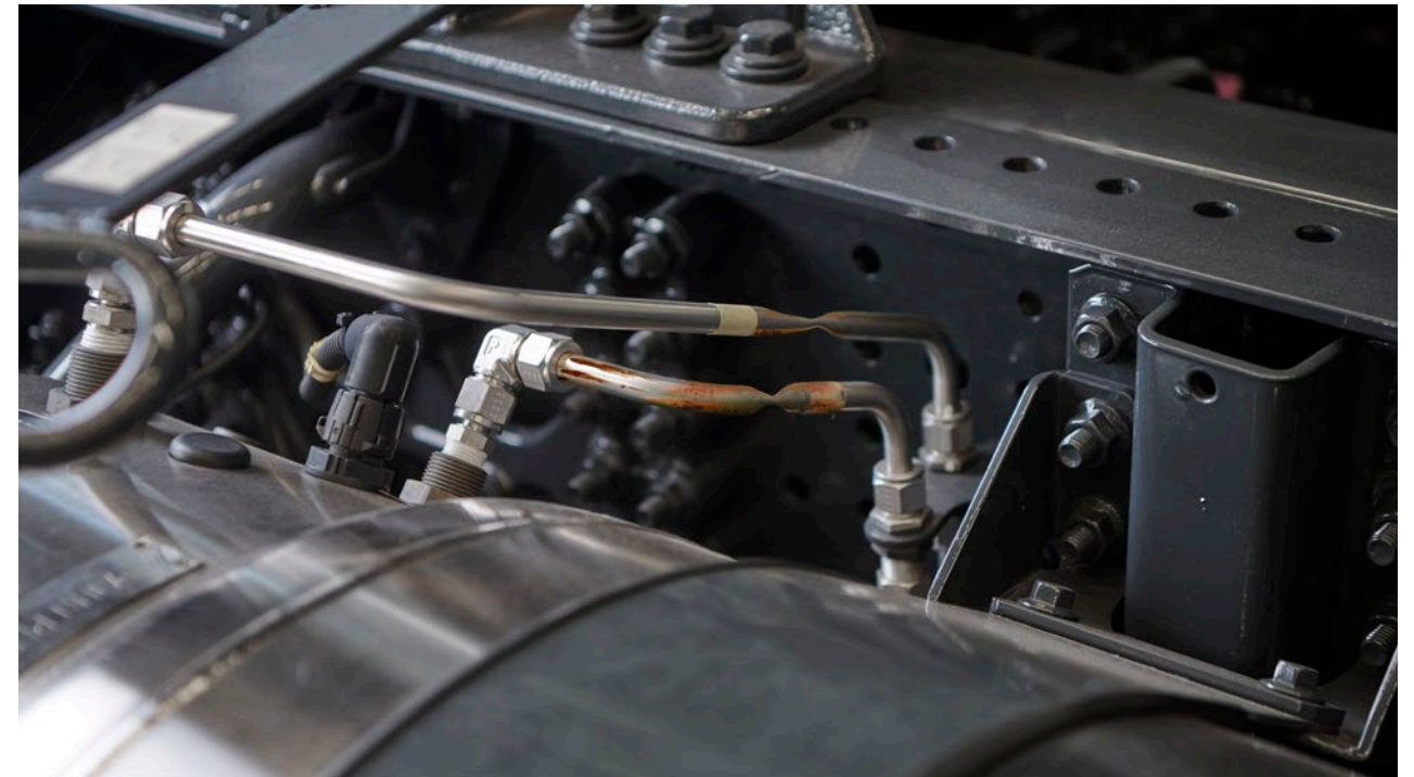
Rost, Dellen, Bruchschäden und/oder Riefen → Berechnung des Austauschs der starren Leitungen.
