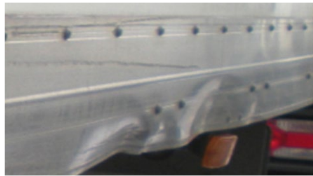
Unterboden-Seitenprofile: Verformungen, die nicht auf wirtschaftliche Weise repariert werden können, Durchdringungen, fehlende Profilabschnitte
